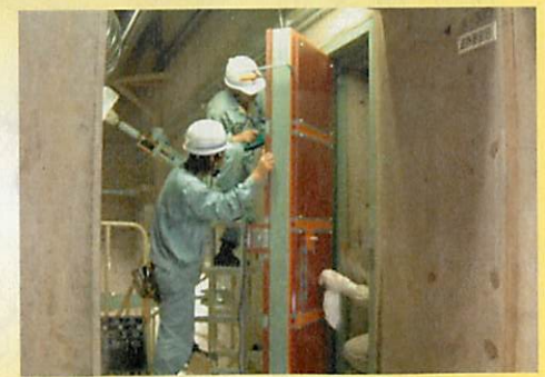
〔断熱材の取付工事〕
