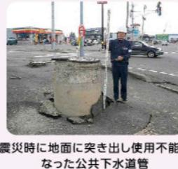
農災時に地面に突き出し使用不能となった公共下水道管
